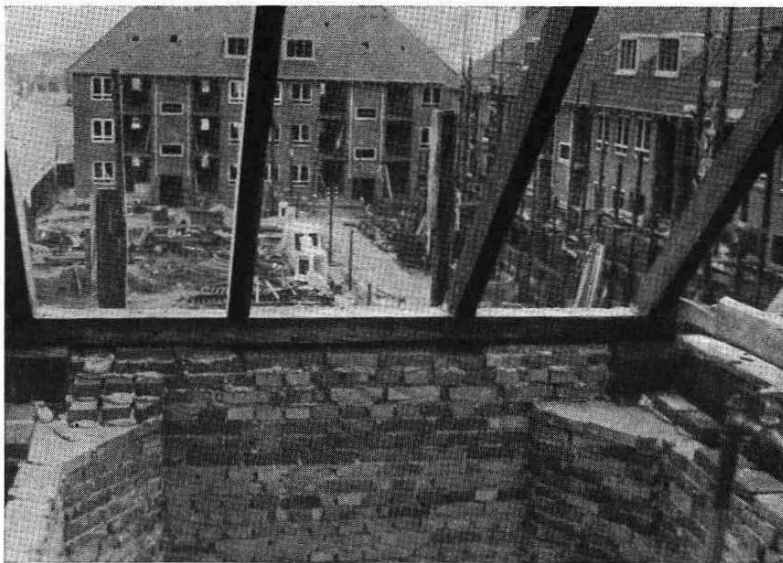
Fig. 27. Tagrems Udformning ved Trappeaabning i Tagbjælkelag.
