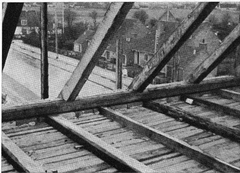
Fig. 5. Spærfagernes Understøtning paa Tagbjælkelaget.
